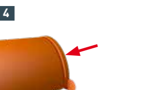
4 Den Klebeendboden noch auf die Dachrinne drücken, dass die Schnittkante nicht mehr sichtbar ist.
