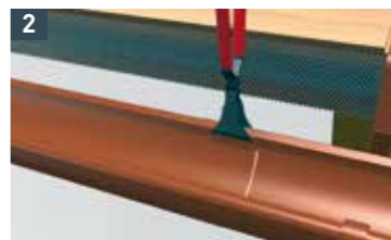
2 Dachrinne mind. 80 mm ineinander drehen und hinteren Umbug schließen.
