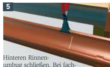
5 Hinteren Rinnenumbug schließen. Bei fachgerechter Klebeverbindung muss Kleber an der Innenseite austreten.
