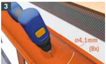
3 Nietbohrungen mit Ø 4,1 mm setzen.
