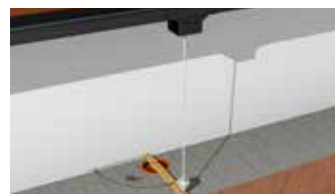
1 PREFA Quadratrohr Kessel lotrecht über den Kanalanschluss positionieren.
