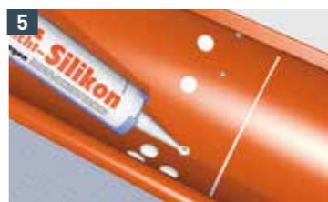
5 Nieten an der Innenseite zusätzlich abdichten.
