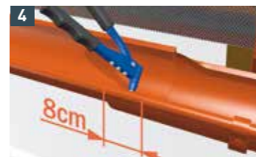
4 Rinne ineinander drehen, eine Niete innen am Rinnenwulst setzen.
