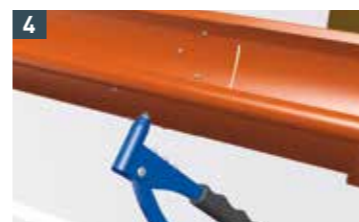
4 Mit PREFA Patentnieten 4 x 10mm im Kreuzstich vernieten - 6 Stk bei 25er Rinne, 8 Stk bei 28er und 33er Rinne, 10 Stk bei 40er Rinne, 20 Nieten pro Naht bei PREFA Saumrinne.
