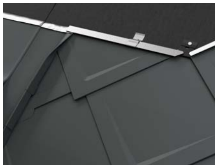
Slika 112 • Strešna lina – posebnost pri strešnem rombu 29 \times 29 in 44 \times 44
